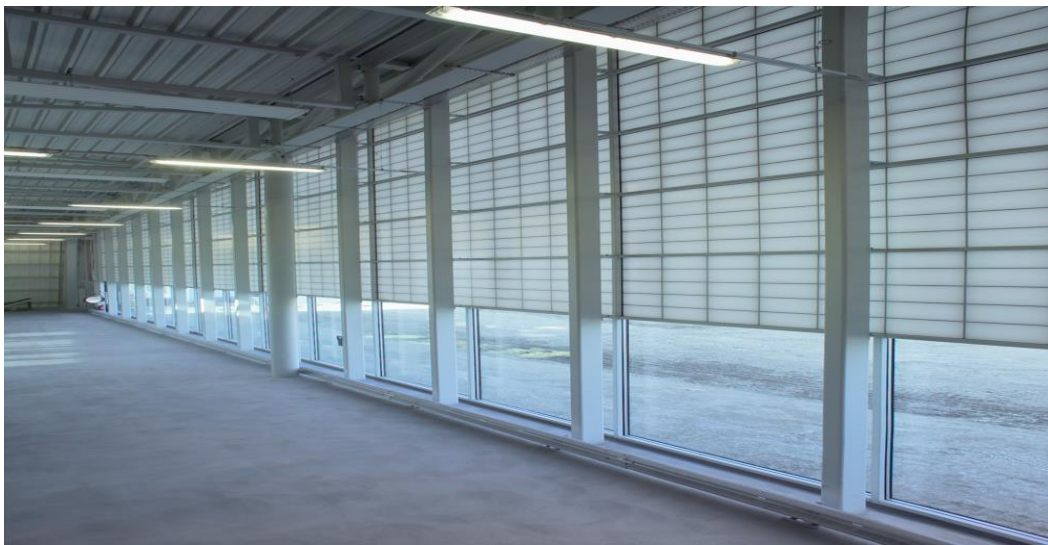
Photo d'une réalisation en Suisse avec façades en panneaux sandwich translucide
